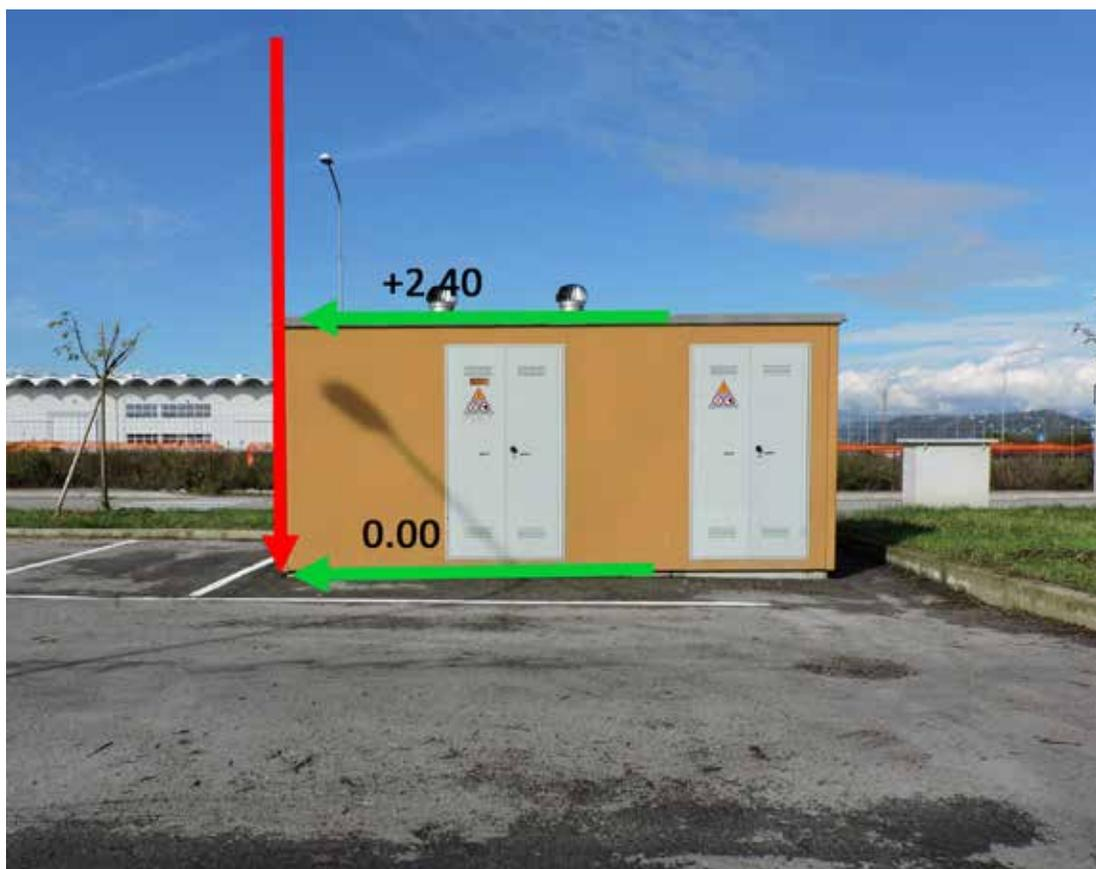
Noi preferiamo, naturalmente se questo è possibile in zona, utilizzare delle particolari tipologie di fabbricato per esempio le cabine prefabbricate per l'erogazione dei servizi energetici spesso presenti nelle zone urbanizzate, poste direttamente ai limiti delle proprietà o in zona pubblica e per la gran parte rappresentate in cartografia. Le altezze ridotte consentendo di porre il punto di riferimento altimetrico anche alla sommità della copertura piana aumentandone la visibilità.
