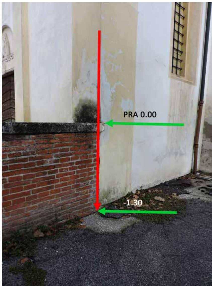
Nel caso seguente il punto, posizionato allo spigolo del fabbricato, non è liberamente accessibile; inoltre la visuale a terra, impedita dall'ostacolo rappresentato del recinto murario, unita alla impossibilità di fissare un Piano di Riferimento Altimetrico (PRA) attendibile, per la mancanza di un qualsivoglia elemento architettonico, lo esclude dalle possibili soluzioni adottabili.
