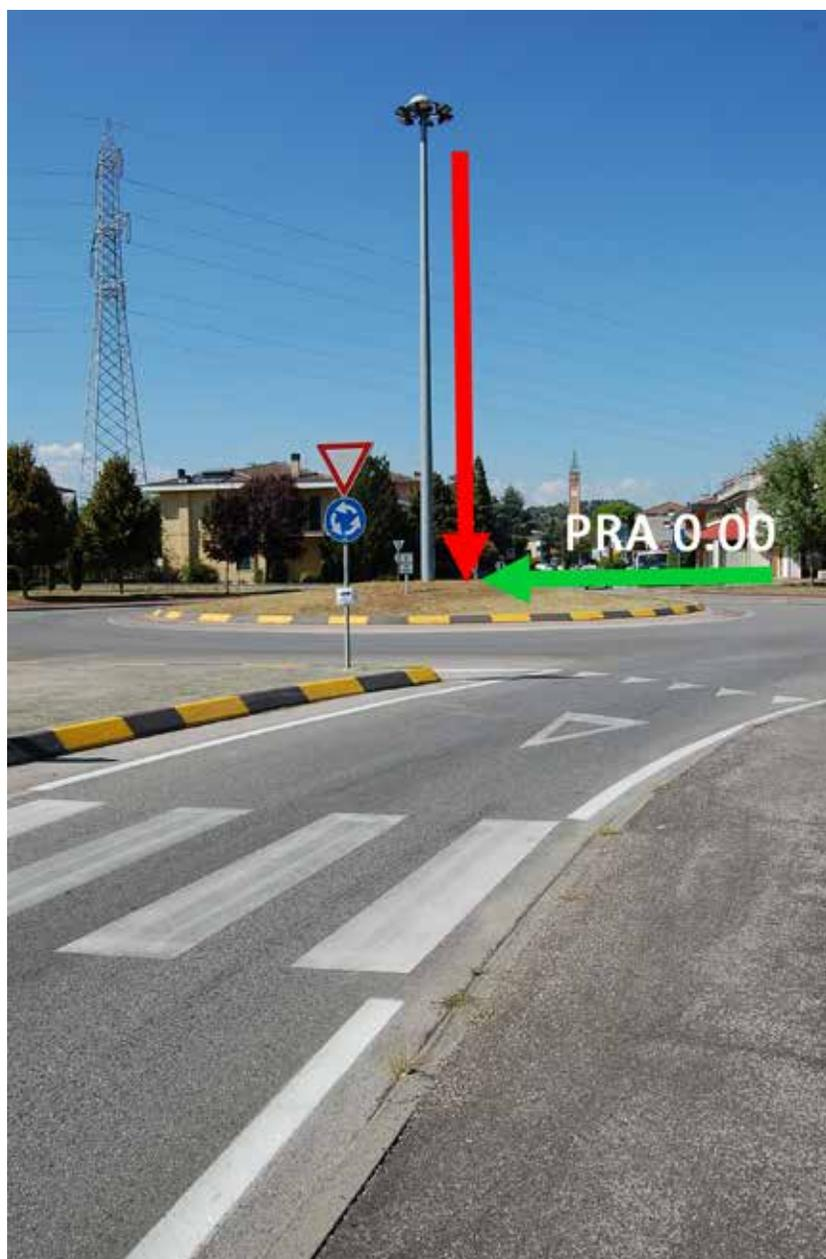
**Punto di riferimento altimetrico.** Il PRA è identificato con una borchia metallica, alla parte orizzontale superiore del plinto di fondazione evitando, per motivi di sicurezza, di porre ogni sistema di mira e misura all'interno dell'area del traliccio se tralicciato.
