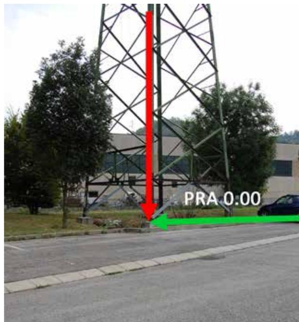
**Punto di riferimento altimetrico.** Utilizziamo sempre una borchia metallica per indicare con certezza il punto di riferimento altimetrico e planimetrico, evitiamo di porre il PRA alla quota del terreno circostante che non assicura per sua natura la necessaria stabilità nel tempo.
